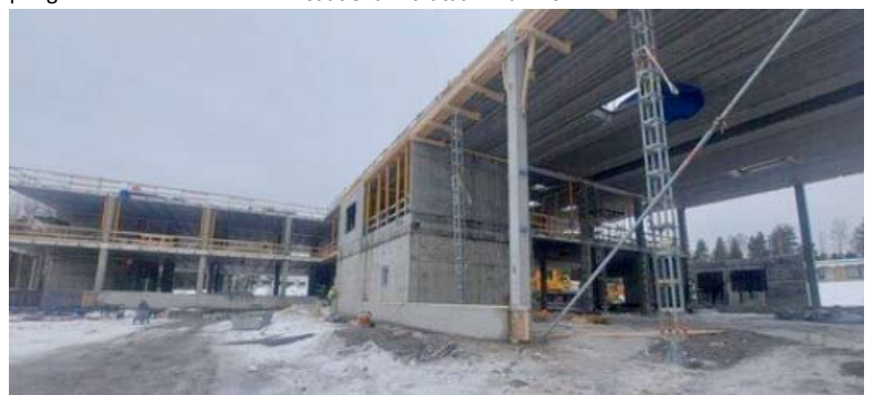
Tässä rakennuksen runkoa ennen seinäelementtien asennusta. Kuvat: Ähtärin kaupunki
