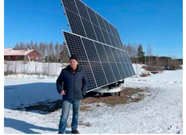
Kuortaneen Lentilässä on kaksi aurinkovoimalaa, joissa on Heikki Kumpulain omaa osaamista runkopalkkien taivuttamisessa pyöreiksi renkaiksi aurinkovoimalaan.
