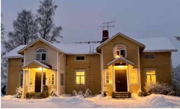
Hyvölän sukutila periytyy jo 1600-luvulta. Tässä rakennus on ilta-valaistuksessa.
