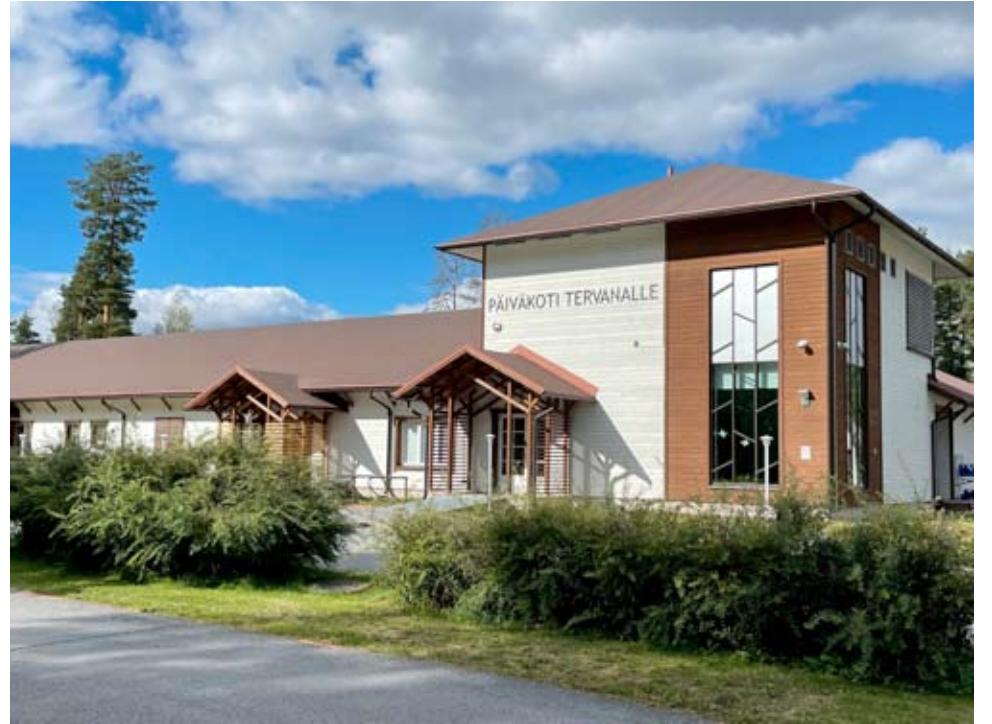
Päiväkoti Tervanalle ryhdytään laajentamaan Alavudella. Pääurakan hoitaa Rakennus-Yliselä Oy.
