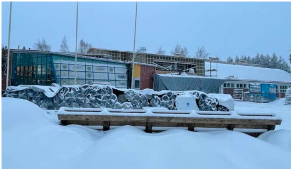
Näin lumisena näyttäytyy Kunto-Lutra, joka valmistuu mittavan remontin jälkeen ensi kesänä. Käyttöönotto on silloin, kun toiminnot taas syksyllä alkavat kesälomien jälkeen.
