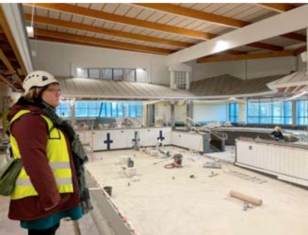
Pääsuunnittelija, arkkitehti Marja Matara-aho katseli pääallasta, joka on nyt valkoista kaakelia. Altaat ovat pysyneet ennallaan, mutta niiden kaakeloinnit on uusittu.
